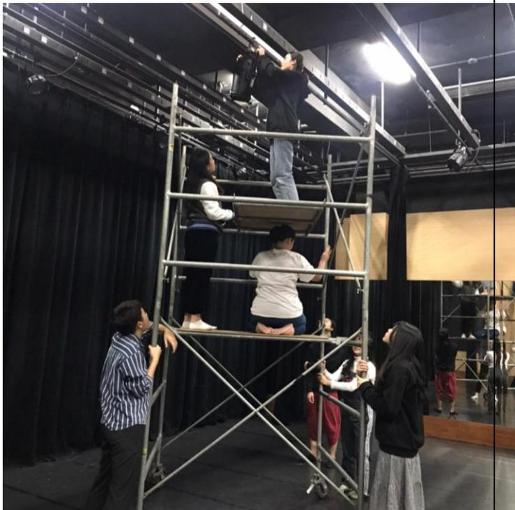
同學在架設好的 Tower 上架設 Par 燈具，中斷同學幫忙遞燈，下段同學負責移動 Tower。
